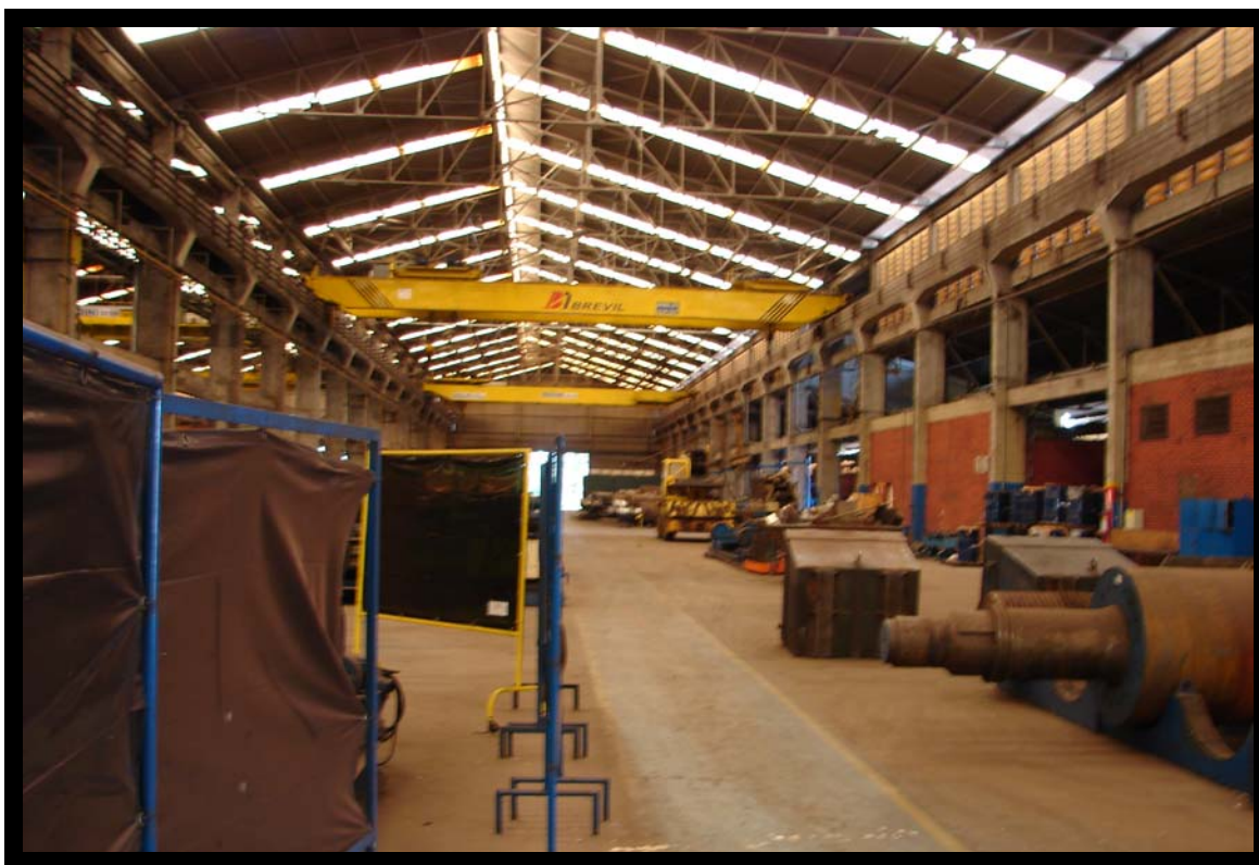
Vista Interna do galpão industrial
