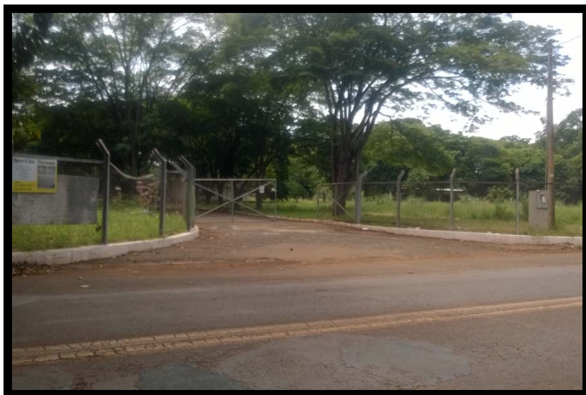
Vista do imóvel
