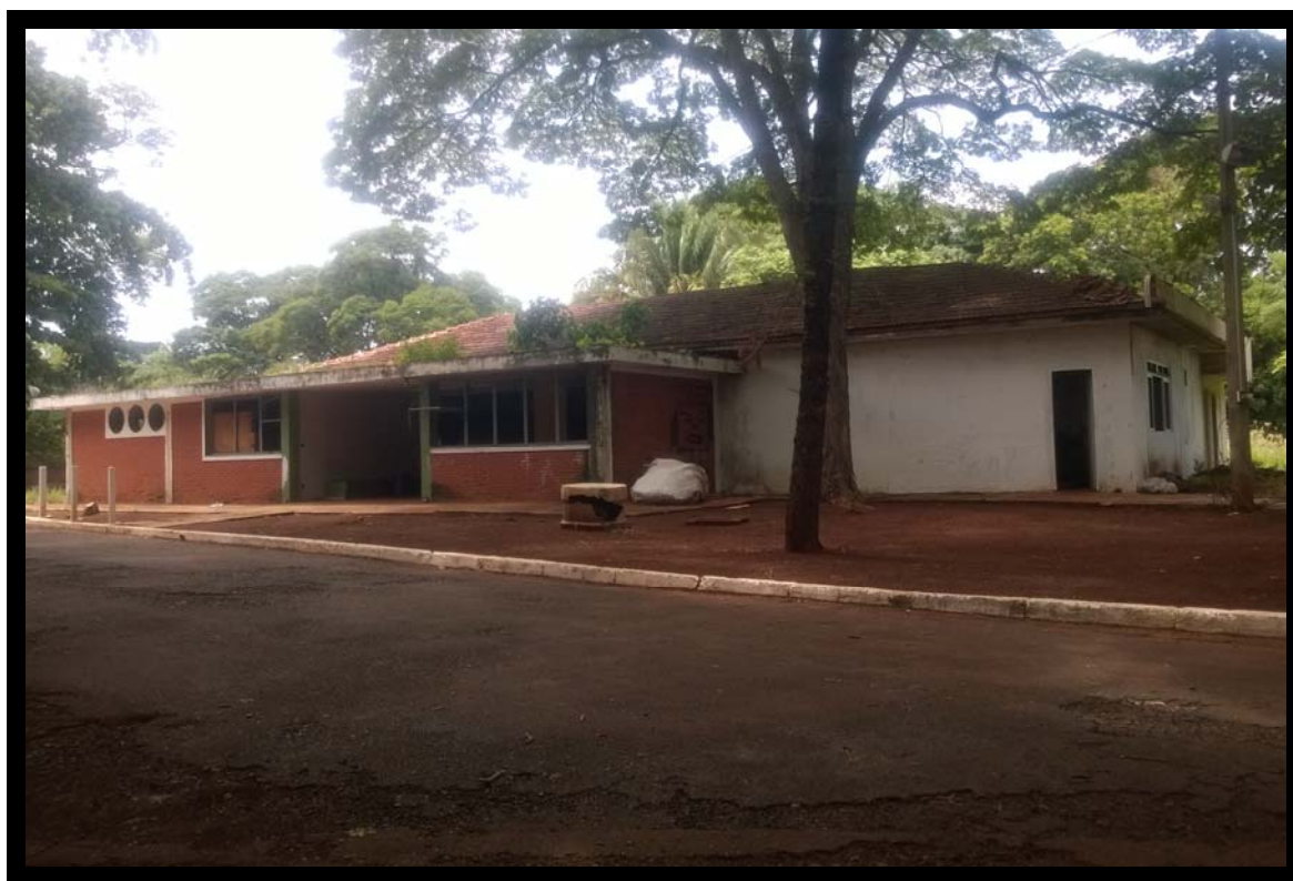
Vista interna das construções existentes
