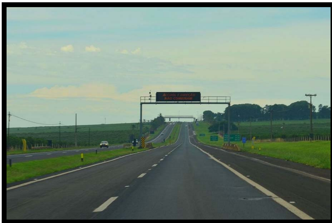
Vista da Rodovia SP 255
