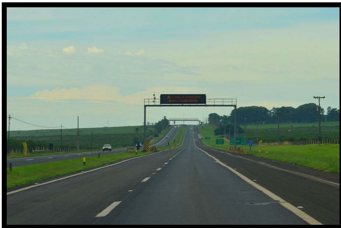
Vista da Rodovia SP 255
