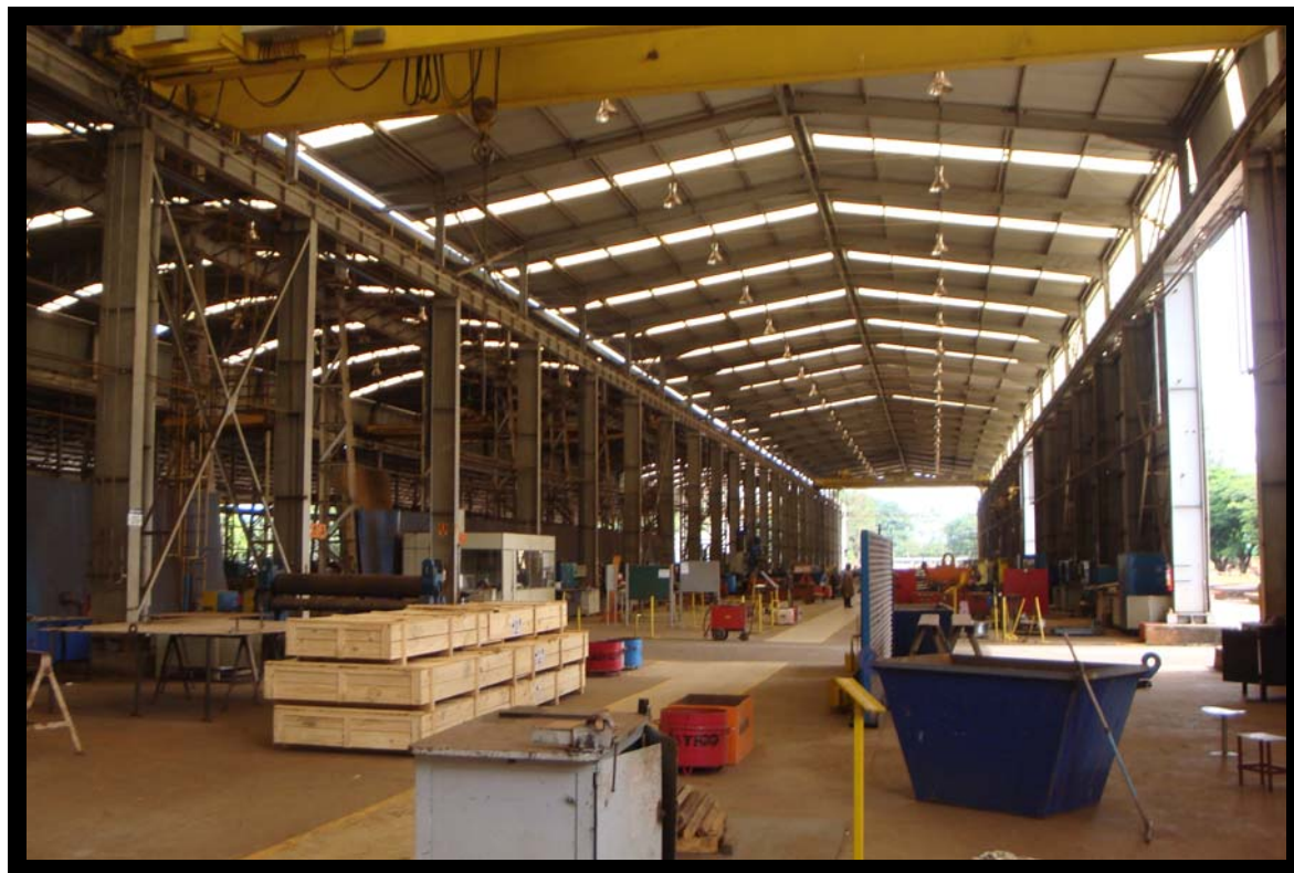
Vista interna da Calderaria
