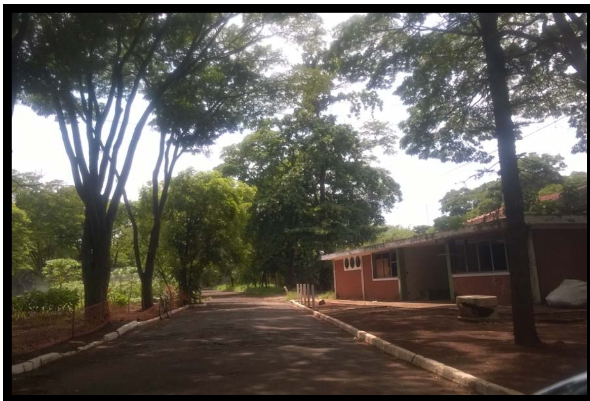
Vista das construções existentes
