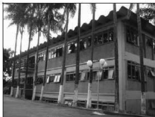
Prédio de Escritórios
