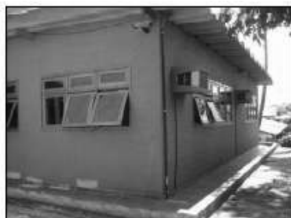
Ampliação térrea do Prédio de Escritórios
