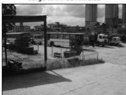
Vista dos Imóveis B, em primeiro plano e C ao lado da área invadida ao fundo (Imóvel D)
