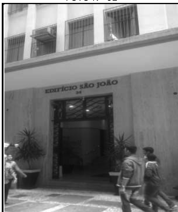
Vista da fachada do imóvel avaliando. Rua Marconi nº 34 – República, SP.
