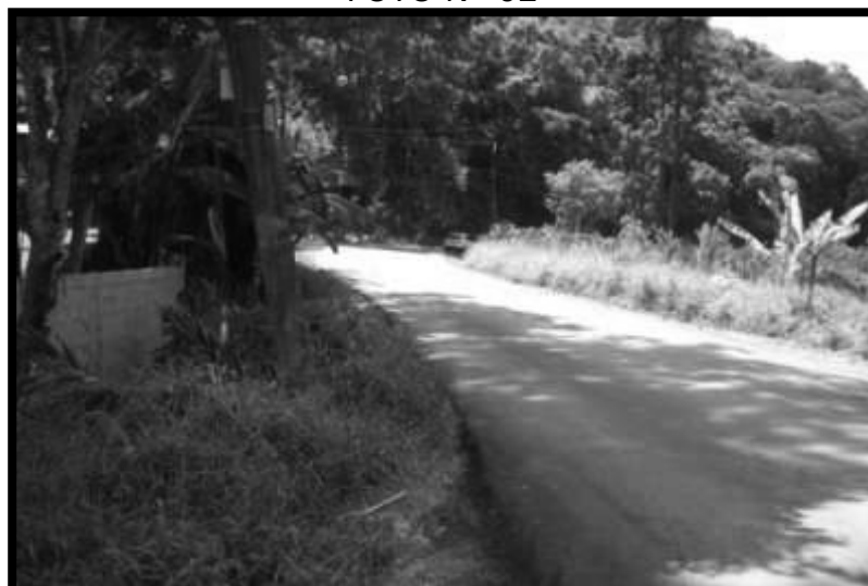
Logradouro de acesso a gleba avaliada. Estrada Djalma Pereira Ribeiro, Potuverá/Engenho. Município de Itapecerica da Serra, SP.
