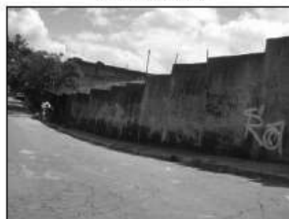
Testada dos Imóveis E e F para a Rua Clemente Bernini
