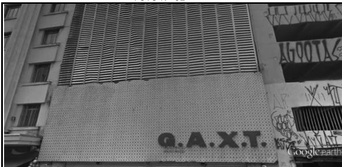
Vista da fachada Rua da Consolação, nº 01 - Consolação, São Paulo, SP.
