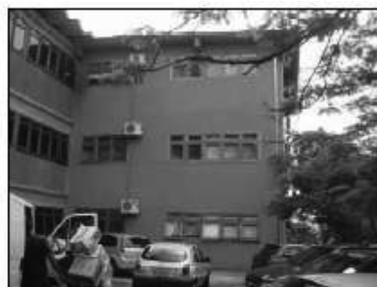
Ampliação do Prédio de Escritórios em 3 pavimentos
