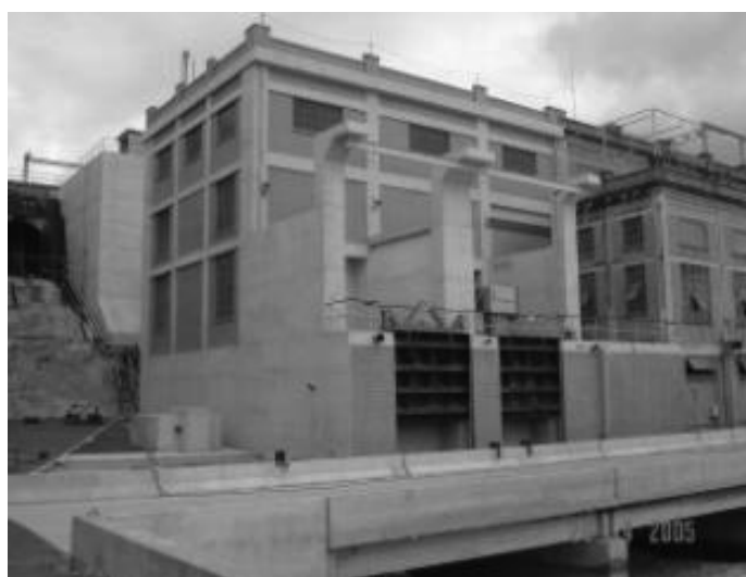
Construção Pesada: UHE - Porto Góes
